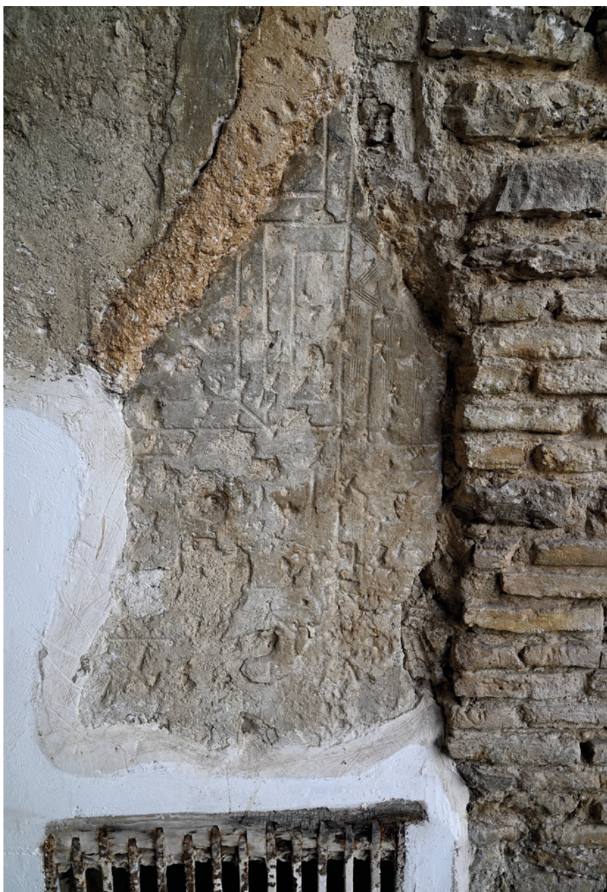
Esgrafiados en un muro de la calle de los Cubiertos. Fotografía de J. A. Falcón
